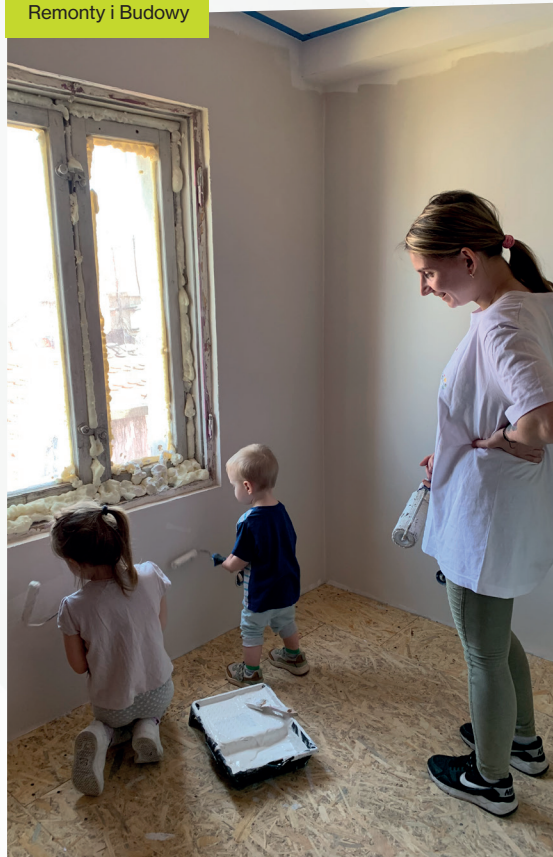
Remonty i Budowy
